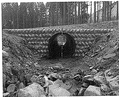
大口径暗渠の布設状況
